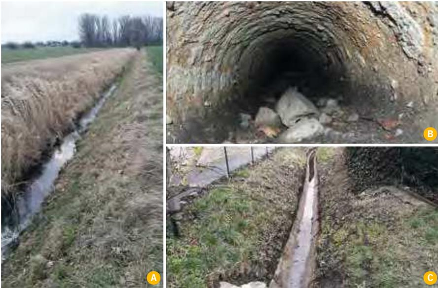
**Menschliche Überprägung von Gewässern – Begradigter Verlauf am Hohen Graben (A), Blick in einen verrohrten Abschnitt des Breitenfelder Mittelgrabens mit groben Schuttalagerungen (B), stark eingegängtes und in Betonelementen geführtes Gewässerprofil am Sommerfelder Graben (C)**
